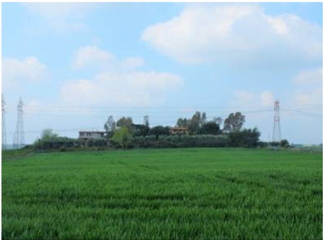
Fig. 22 Ville residenziali su via di Torremaggiore.
