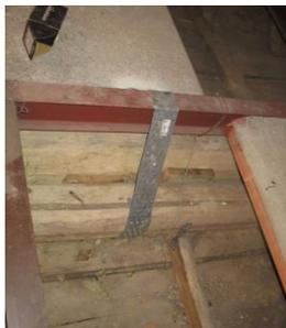
Fig. 27, 28) Varoni, Santa Maria delle Grazie, sottotetto, connessioni metalliche tra l'orditura principale e secondaria con nastro forato
