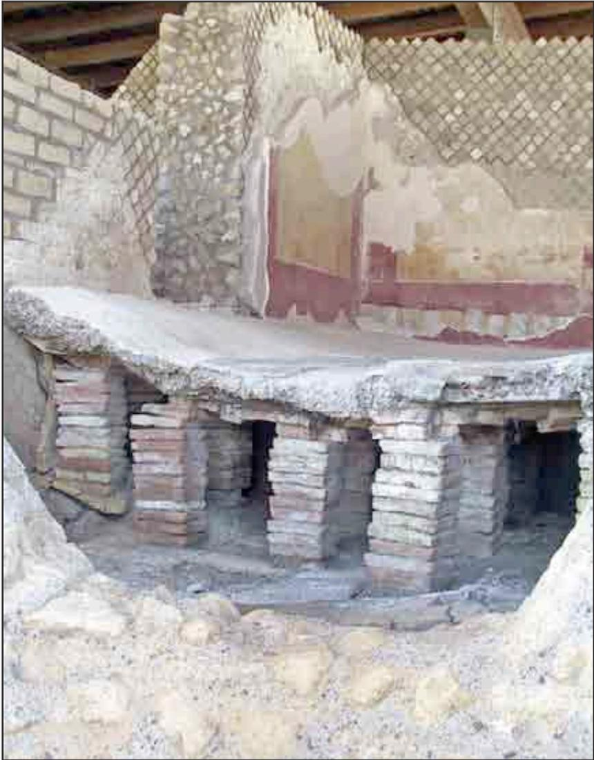
*Ambiente con pavimento su suspensurae e tubuli per l'aria calda sulle pareti.*
